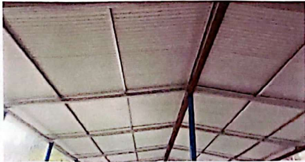
se observa el techo de la cocina ya finalizado
