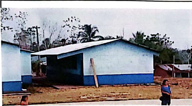
se observa el techo nuevo del establecimiento ya finalizado
