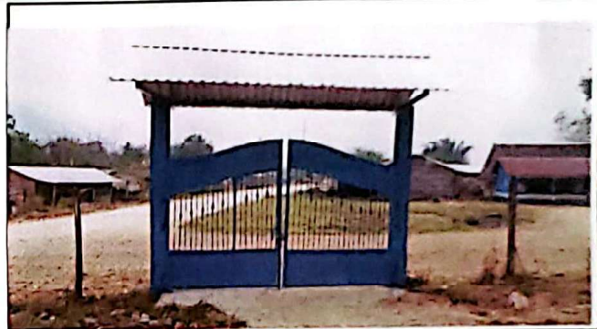
se observa el porton del establecimiento ya terminado
